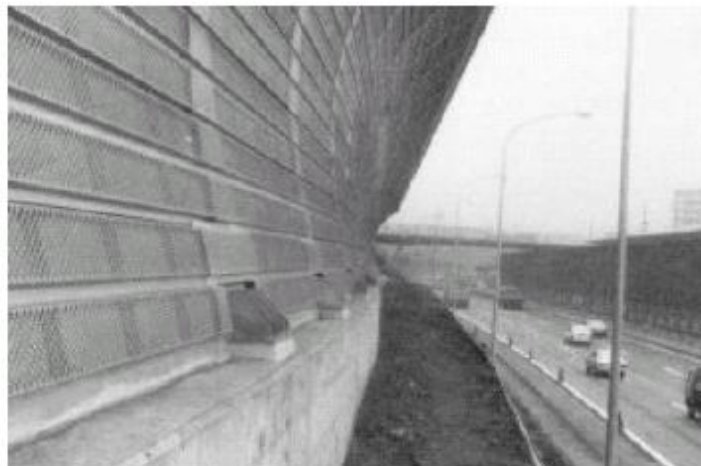
Tokyo, route à circulation rapide - [barrières anti-bruit]
